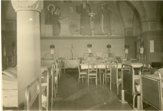
1: Historische Aufnahme mit Blick in Richtung der Nordwand: Während der Nutzung als Lazarett im Zweiten Weltkrieg war die Trennwand ausgebaut.
