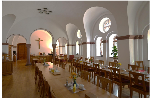
4: Gästerefektorium mit Blick nach Süden: Tonnengewölbter Raum mit Stichkappen; Räumliche Gliederung mittels dreiteiliger Bogenwand; rundbogige Fenster­nischen mit je zwei Rundbogenfenstern und Okulus.
